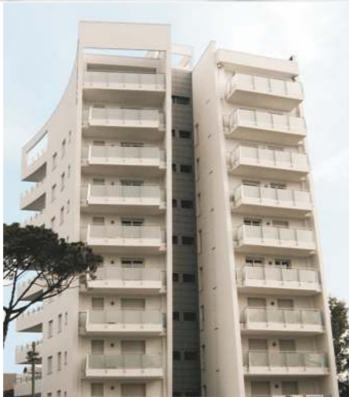
L'esperienza maturata da Waler è visibile in milioni di metri quadri di cappotto realizzato in tutta Italia e in Europa.
