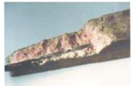
Un indicatore chimico della carbonatazione è la fenoftaleina: dove il calcestruzzo è violetto l'ambiente è alcalino.
