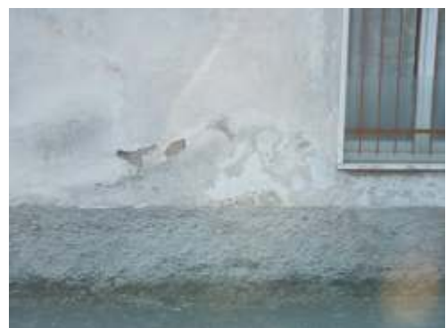
Distacco di intonaco a causa di umidità di risalita capillare
